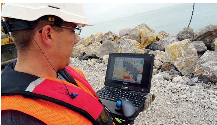
Damien vérifie sur son ordinateur portable que les blocs sont posés à l'endroit précis, selon un plan établi à l'avance.
