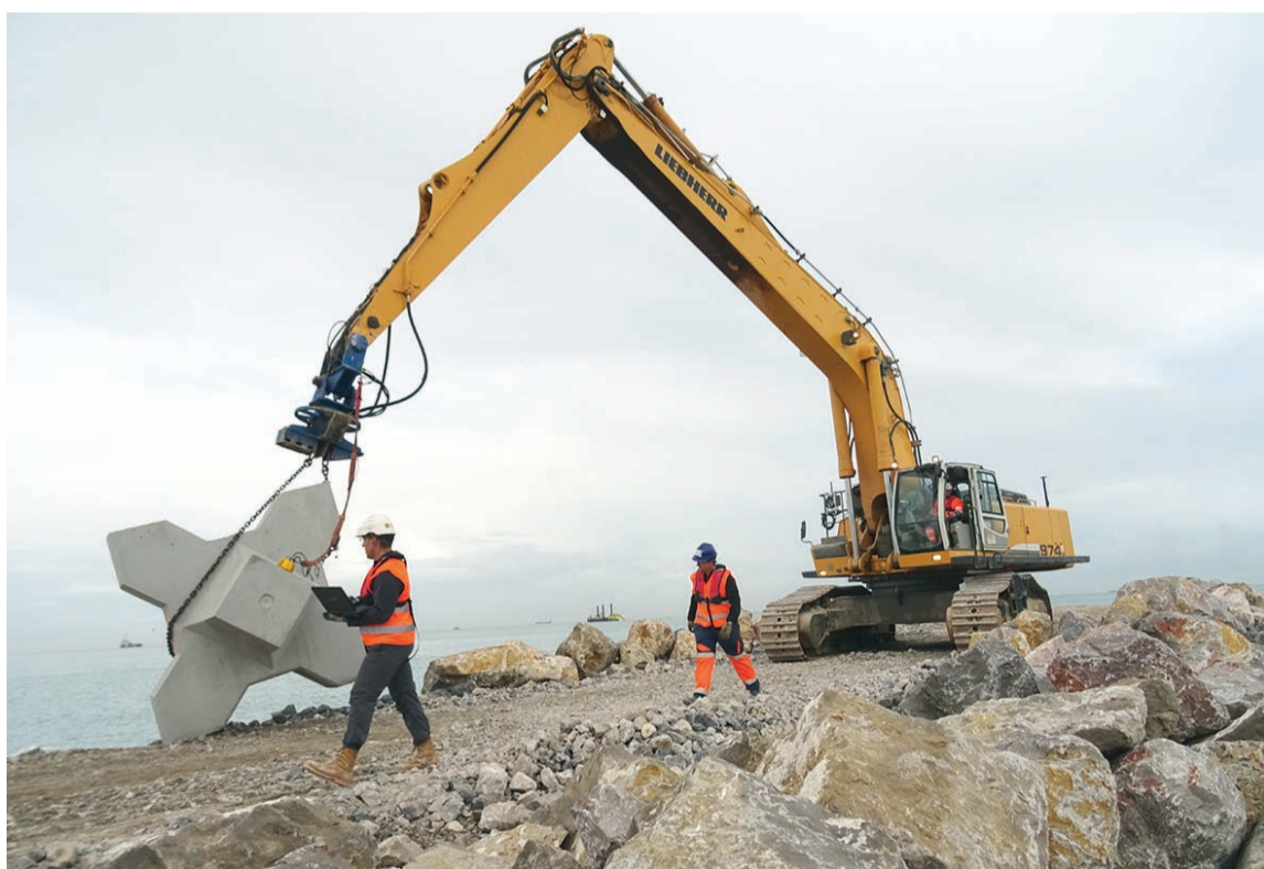
Composée d'enrochements et de blocs béton, la nouvelle digue est conçue pour résister à une crue centennale. 650 mètres ont été réalisés sur les 3,3 km prévus. Elle protégera l'accès aux trois futurs postes dédiés aux ferries de grande capacité. (Photos Mathieu Hébert)
